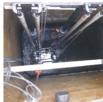
槽内清掃作業後
