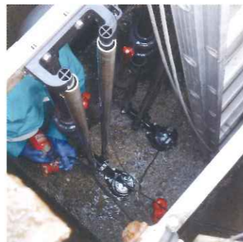
槽内清掃作業中
